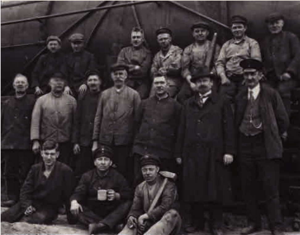
Arbeitspause in den Eisenbahnwerkstätten Potsdam
